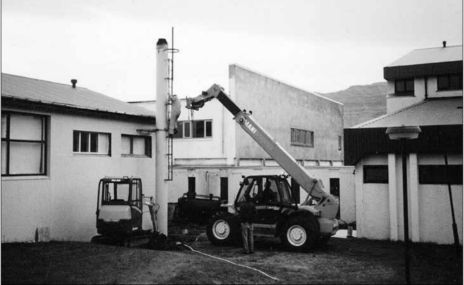
Unnið að uppsetningu á nýjum olíukatli við grunnskóla og íþróttahús. Heitir pottar komu í kjölfarið.
