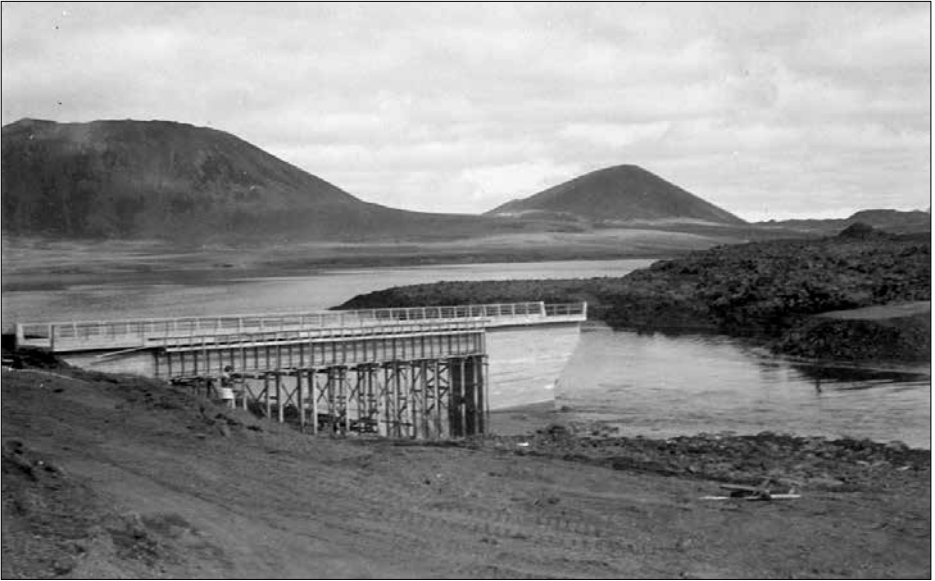
Brúin á Mjósundin í byggingu og byrjað að fylla upp sundið að brúnni. Ljósma.: Halldór Finnsson.
