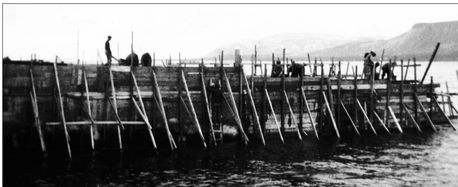
Bryggjuframkvæmdir í Grundarfirði.
