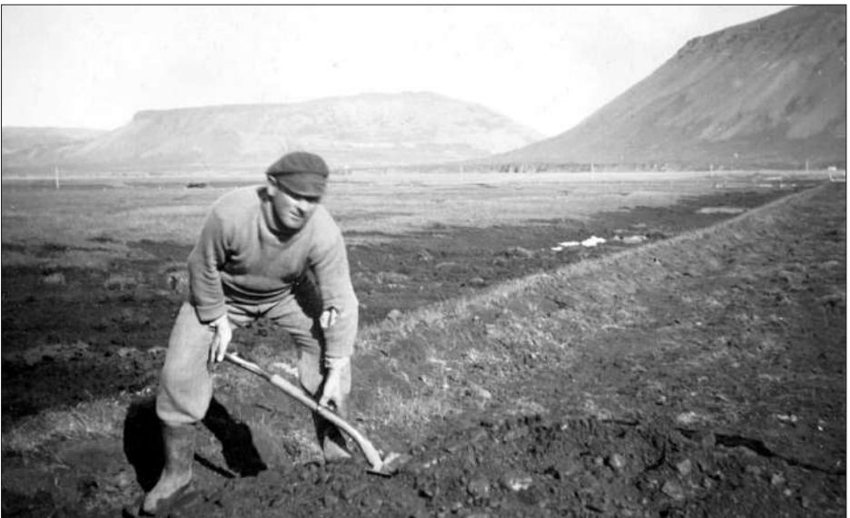
Elberg í vegavinnu. Hér sést hvernig vegir voru lagðir.
