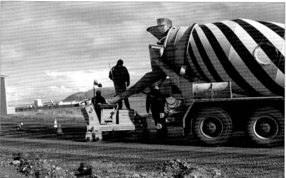
Framkvæmdir við hverfisvæna leið á Grundargötu.
