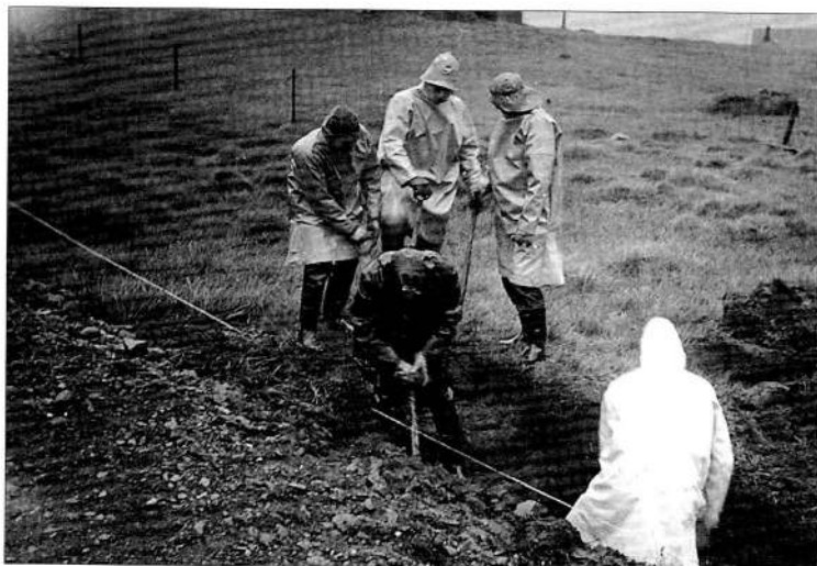
Framkvæmdir við kirkjuna að heffast. Úr myndasafni Eyrbyggja.
